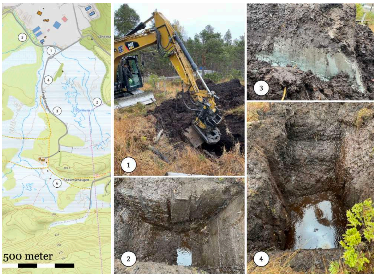
Figur 3. Lokasjon av prøvegravingene (PG) omtalt i teksten (venstre) og bilder fra selve prøvegravingen lokasjon PG2 der massene i all hovedsak består av «blautmyr» (fra Siggerud, 2022c)
