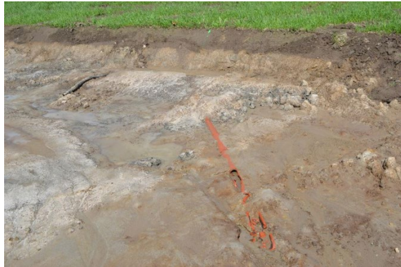
Figur 8 Avgravde grøfter på O2-feltet på Bogstad (til venstre), brudd på grøfterør som gir utlekking av vann over stort område på tilbake stillt jordbruksareal på O2-feltet på Bogstad (til høyre) (Foto: Trond Knapp Haraldsen).
