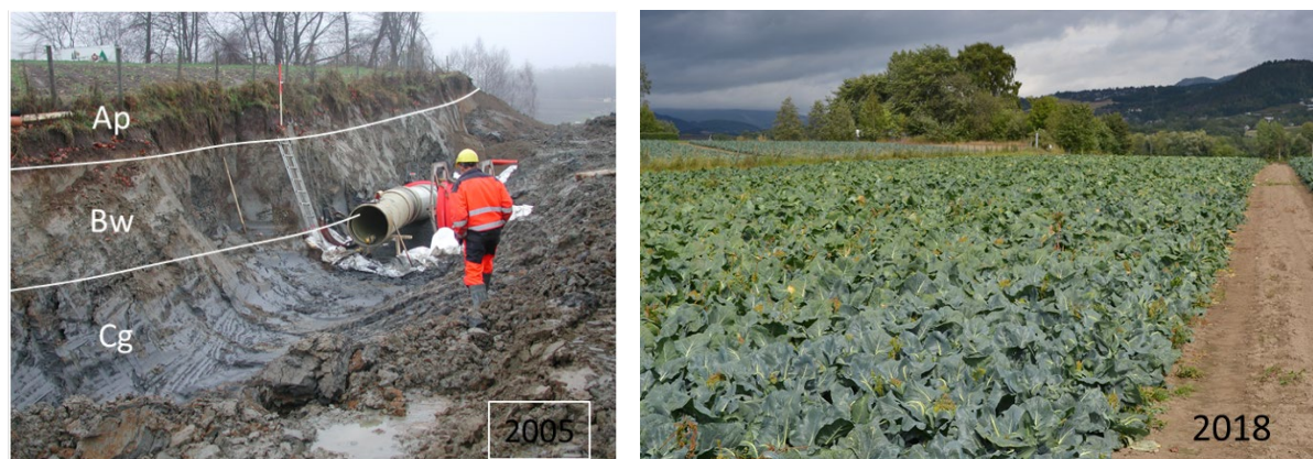
Figur 18 Vannledningsgrøft i Lierdalen med inntegnede sjiktgrenser i jordprofilen (til v.) og reetablert jordbruksareal med kålvekster (til h.) (Foto: Trond Knapp Haraldsen).
