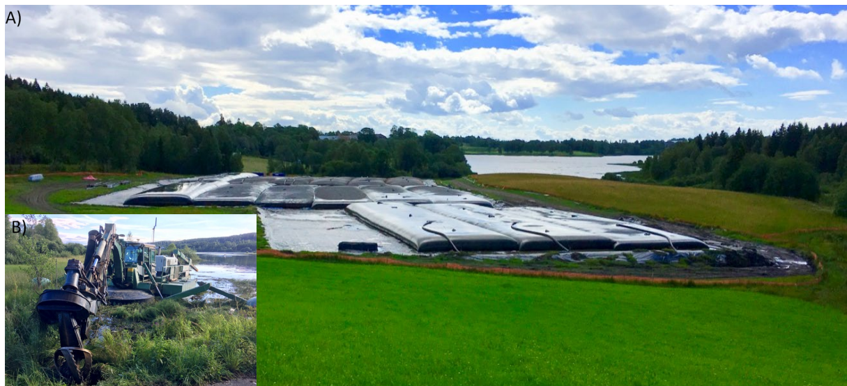
Figur 7 A) Avvanningsområdet med Geotuber på avvanningsområdet og Bogstadvannet i bakgrunnen. De sorte Geotubene ble stablet i 2 - 3 høyder. Vann fra avvanningen drenerte til et membran-dekket basseng og videre til Bogstadvannet. B) Hydraulisk mudring ble utført med en WaterMaster som kuttet, sugde og pumpet sedimentene i rør til Geotubene (Foto: Arnt Olav Håøya).
