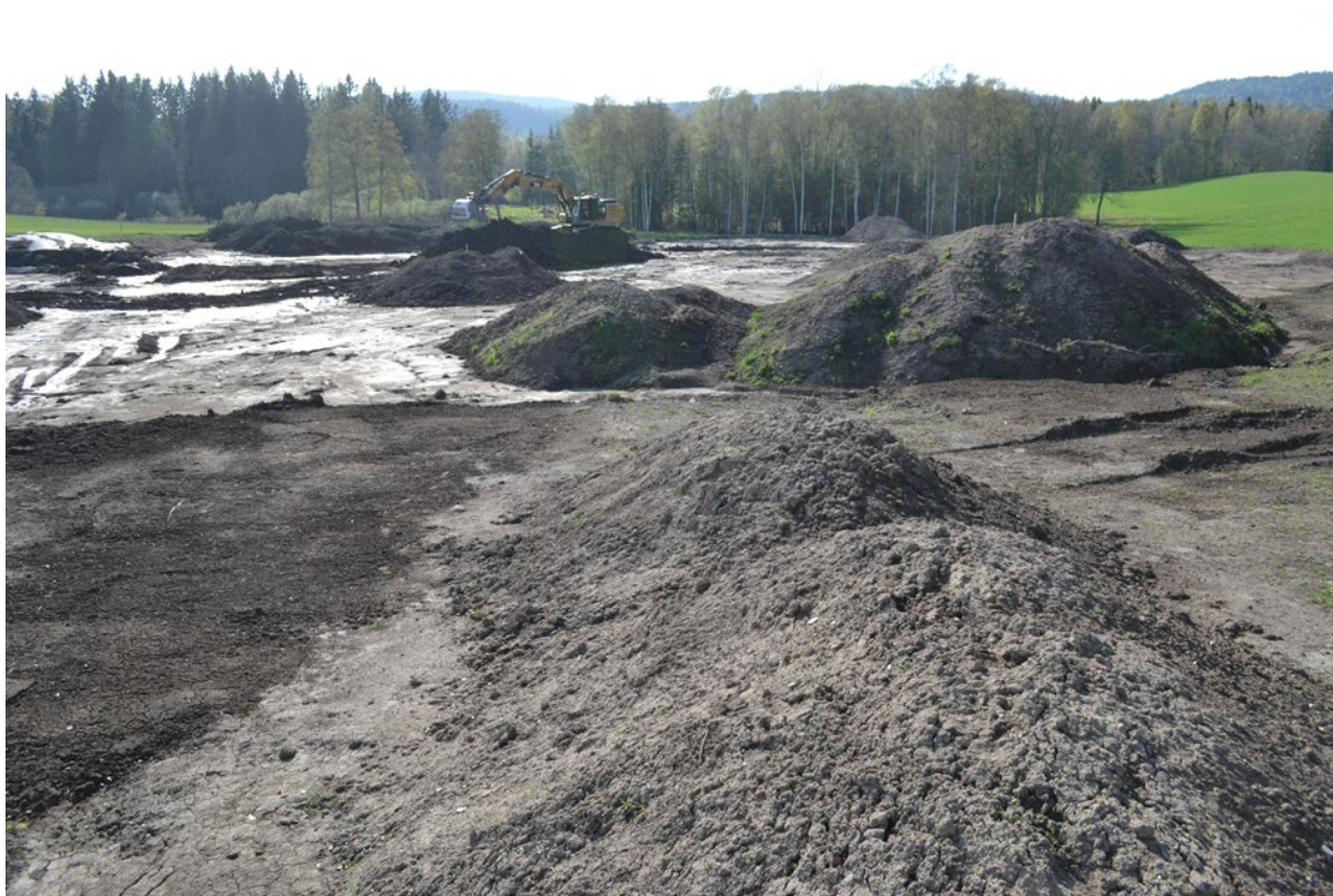
Figur 10 Jordhåndteringen ved tilbakeføringen av avvanningsområdet på Bogstad til jordbruksareal ble gjort med 30 tonnns beltegravemaskin (Foto: Trond Knapp Haraldsen)
