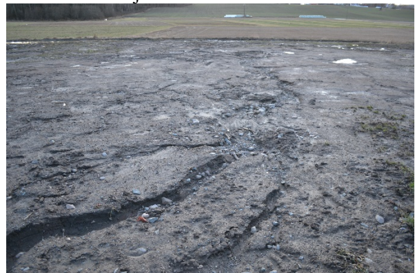
Figur 6 Midlertidig masselager under tilbakestilling til jordbruksareal med betydelig erosjon (til høyre) (Foto: Trond Knapp Haraldsen).
