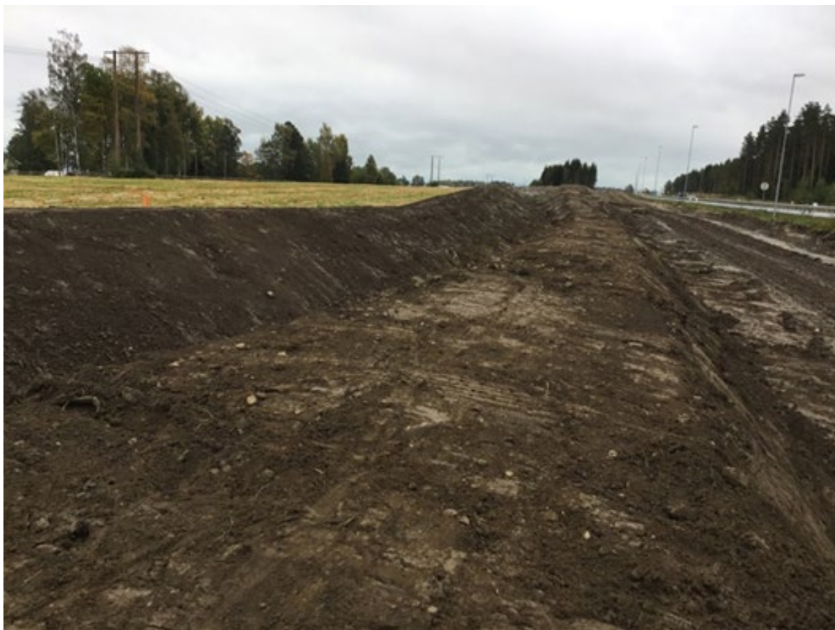
Figur 22 Midlertidig masselagring av jordranker langs E6 i Stange (Foto: Pauli Nordvåg, Hæhre entreprenør AS).
