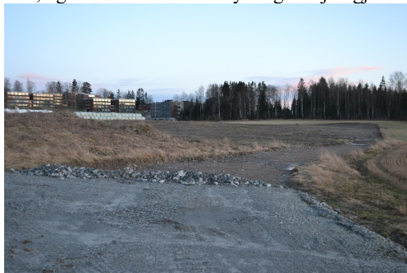
Figur 6 Midlertidig masselager under tilbakestilling til jordbruksareal med betydelig erosjon (til høyre) (Foto: Trond Knapp Haraldsen).
