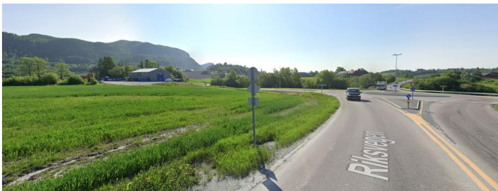
Figur 20 - Google maps bilde fra 2023, etter at tiltakene ble bygget.
