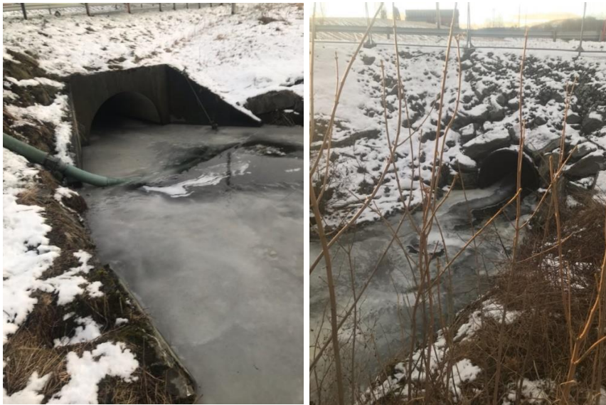
Figur 14 - Bilde av dagens kulvert (Kilde: Bilder tatt av grunneier).
