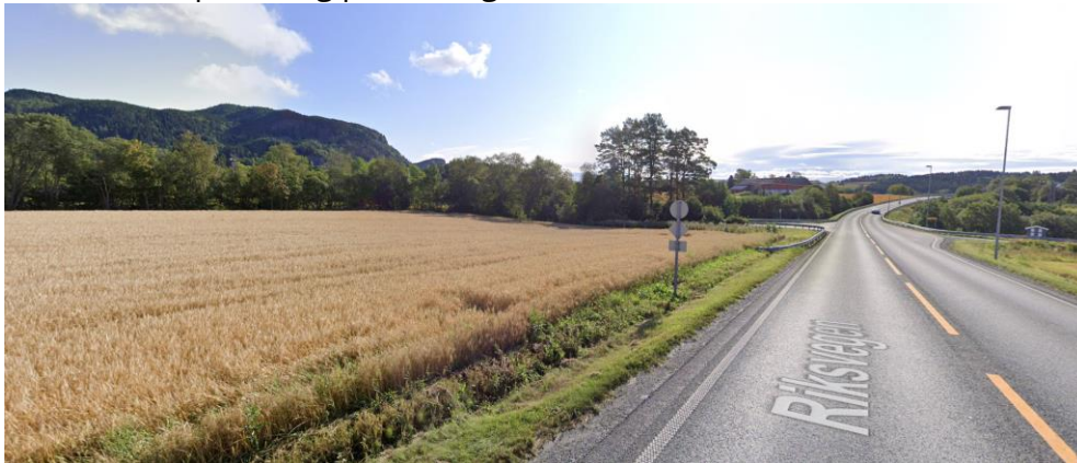
Figur 19 - Google maps bilde fra 2019, før tiltakene ble bygget.
