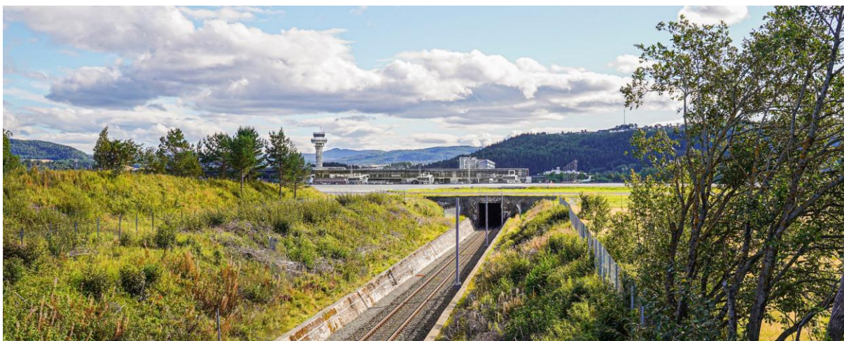
Trondheim lufthavn Værnes(foto Sunniva Reitan, Stjørdal kommune)
