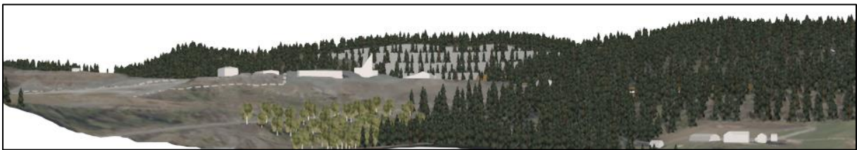
Figur 30. Fjernvirkning etter tiltak i utredningsområdet. Sett fra Jullumsvegen 33.
