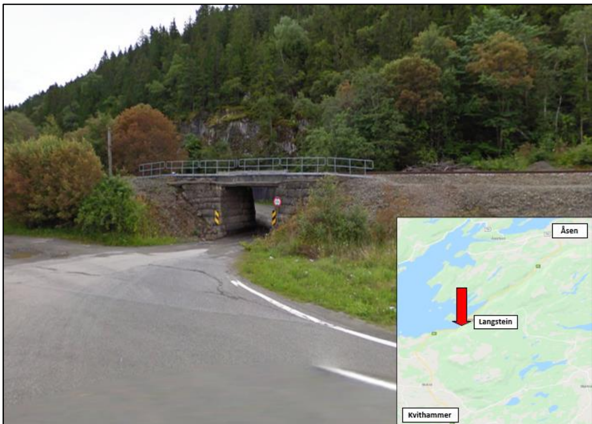
Figur 3.1 Dagens situasjon ved Langstein, undergang sett fra vest mot øst (kilde: Google maps)
