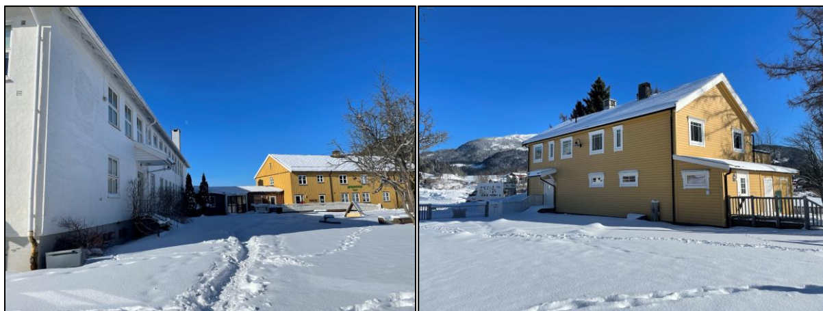
Figur 5.13: Eksisterende bebyggelse innenfor B1 og B2. Bebyggelse innenfor BK2 som er forutsatt revet i planen t.h.
