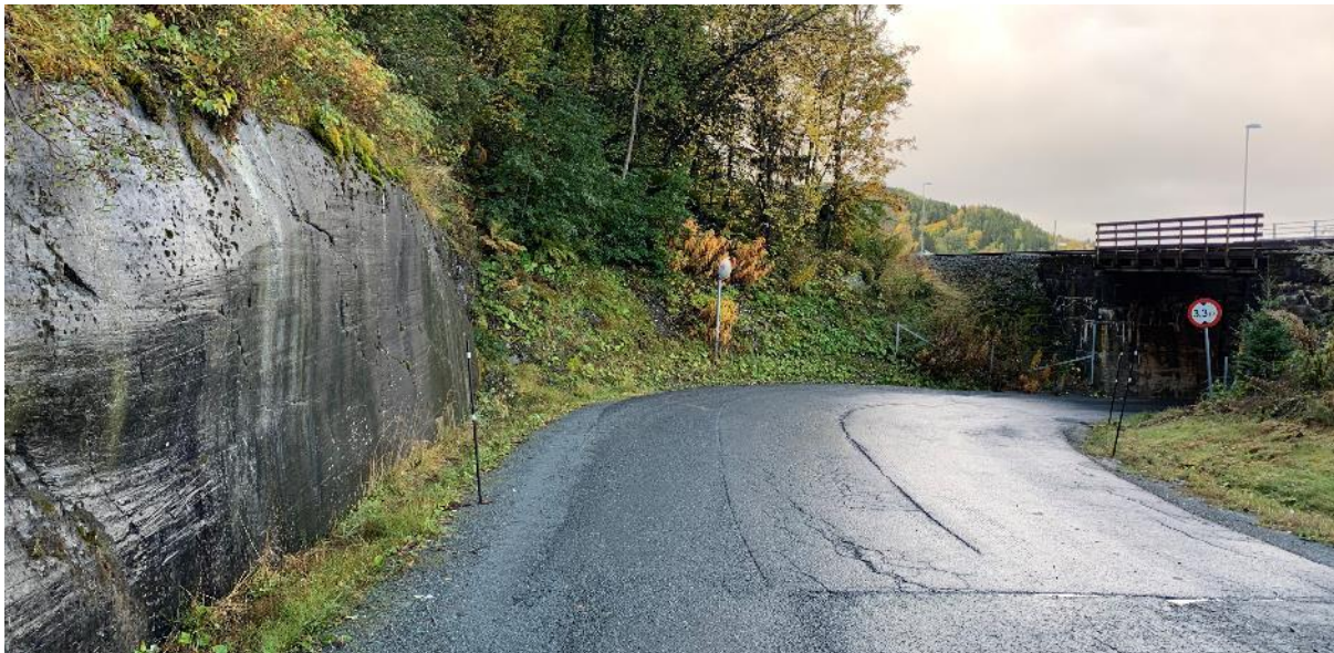
Figur 4-2 Langsteinvegen og undergang, retning mot sør/sørvest.
