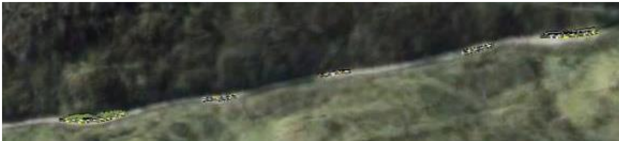
Figur 4-6 Utvidelser i Langsteinvegen, halvdel nærmest anlegget
