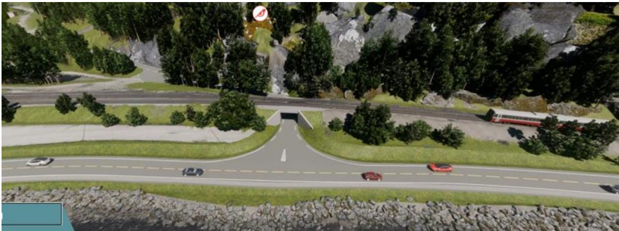
Figur 4-4 Illustrasjon av fremtidig T-kryss og undergang
