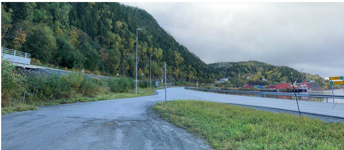
Figur 4-3 Innkjøring til undergang fra E6, høyresvingefelt midt i bildet for kjørende på E6 fra sør.
